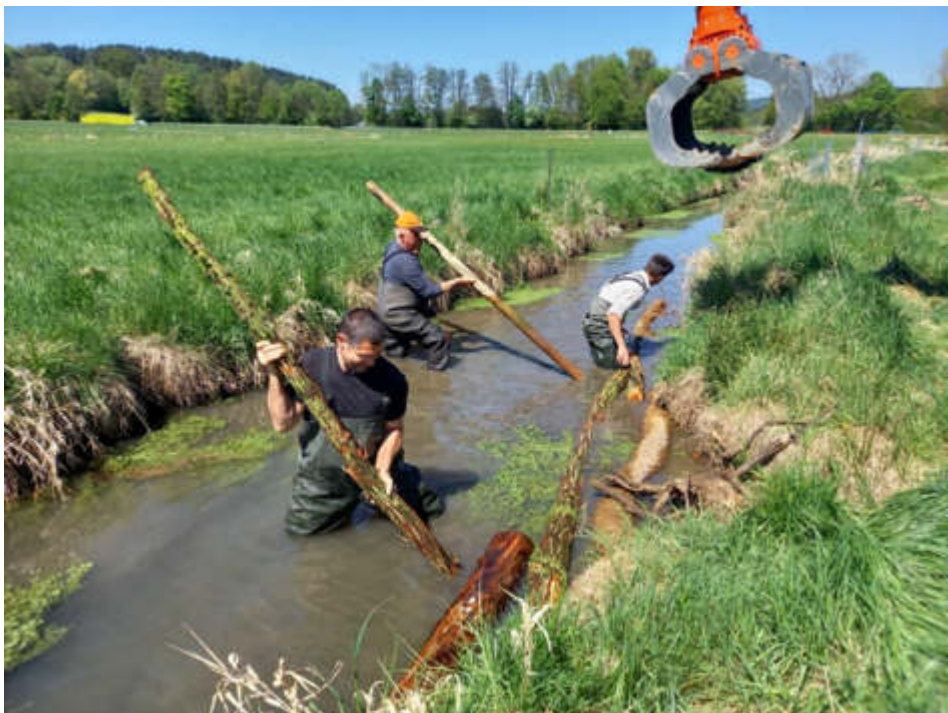
Wurzelstock, Kokosfaschine und Totholzstämmen dienen hier als Ufersicherung und Lebensraum für Fische und Insekten. Die gute Zusammenarbeit zwischen Baggerfahrer und Landschaftspflegern im Wasser ist für eine sinnvolle Umsetzung Grundvoraussetzung.
