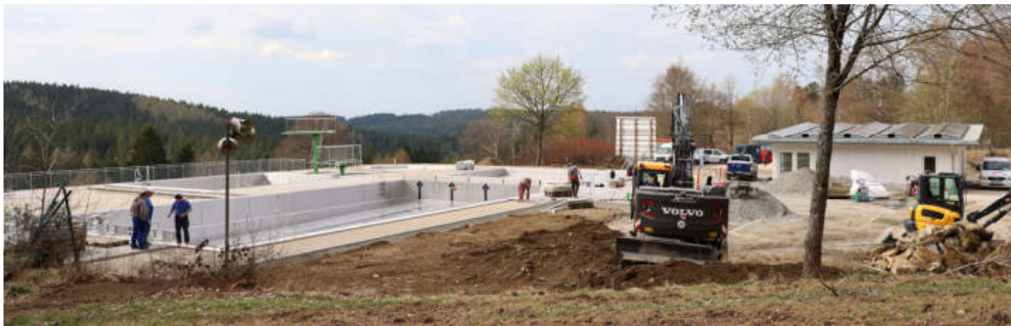
In den Endzügen liegt die Sanierung des Bischofsgrüner Freibads.
