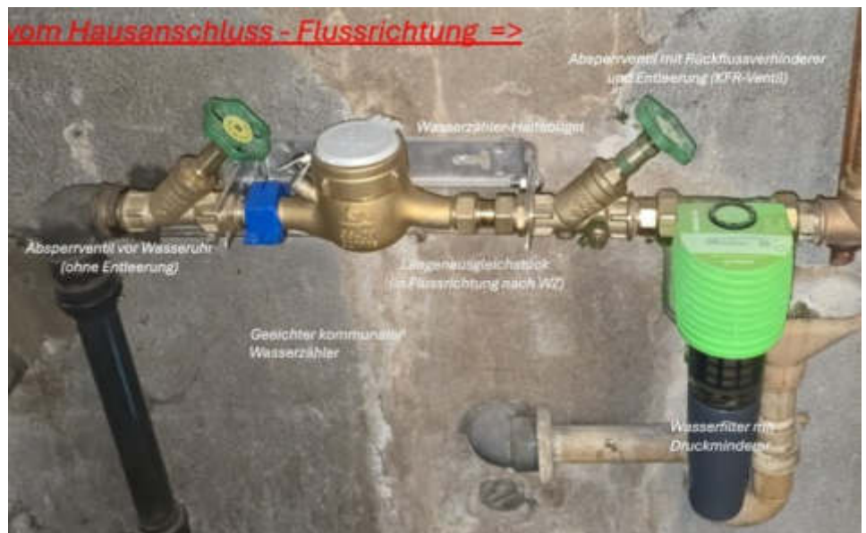
Das Abgebildete Foto/Schema zeigt eine korrekt installierte Wasserzähler-Anlage nach DIN1988
